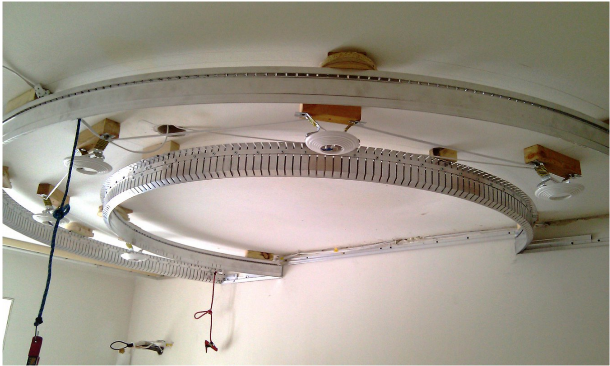
Рис. 9.4. Завершенная конструкция потолка
