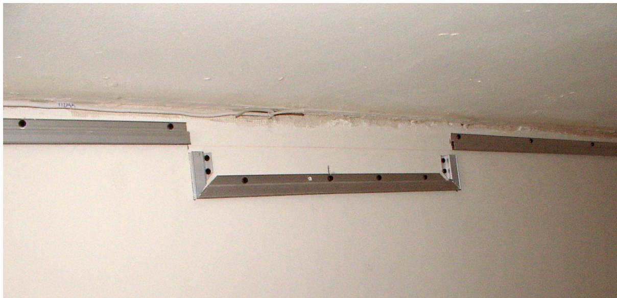
Рис. 9.1. Установка стенового профиля для формирования ступенчатого перехода
