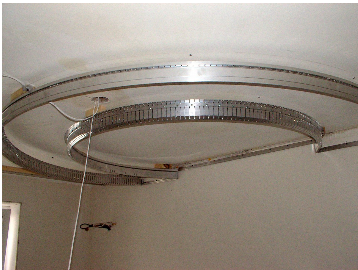
Рис. 9.3. Формирование криволинейных участков при помощи профилей «Прозет»
