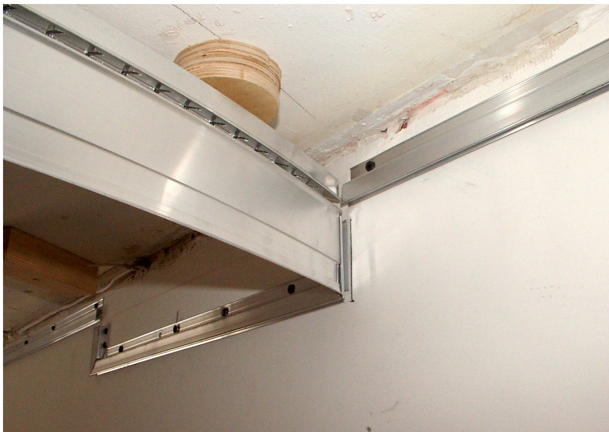
Рис. 9.2. Стыковка профиля «Прозет» со стеновыми профилями
